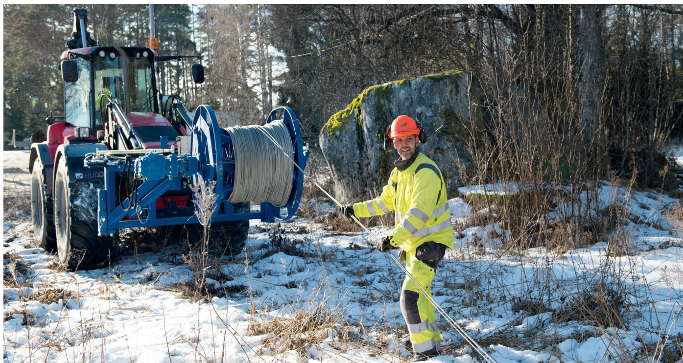
Trumgripen spolar in raserad metall lina i Kobo med hjälp av Björn Johansson, Elmontör, Upplands Energi
